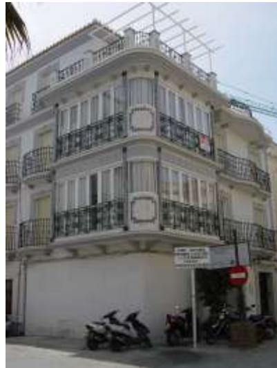
Edificaciones en el borde Noroeste del conjunto histórico
