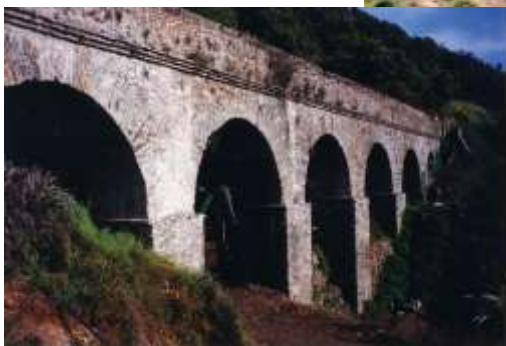
Fotos actuales del acueducto
